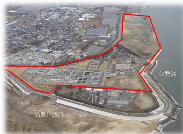
【北勢沿岸流域下水道(南部処理区)南部浄化センター】
