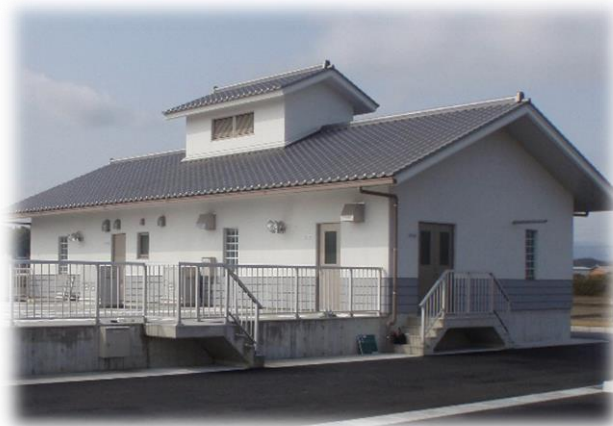
【農業集落排水施設（三宅・徳居地区浄化センター）】
