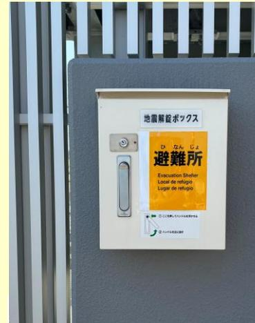
震度5弱の揺れを感知して、避難所の鍵を収納したキーボックスが自動で解錠します。
