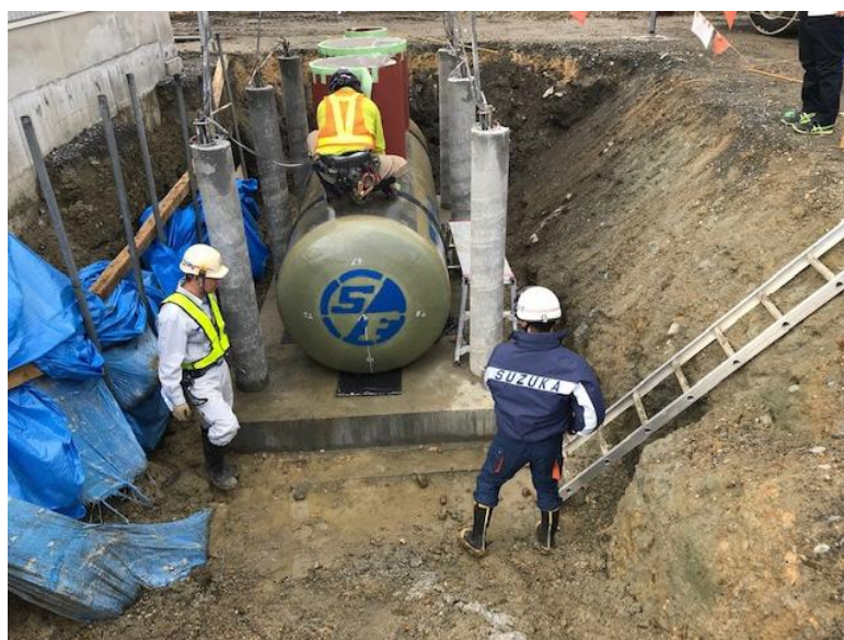
地下タンク中間検査
