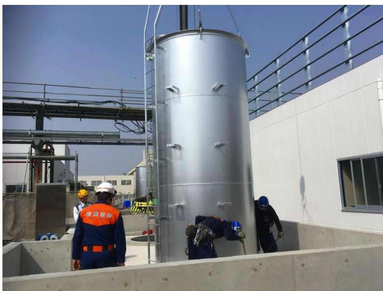
屋外タンク中間検査
