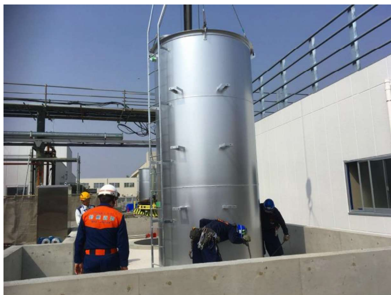
屋外タンク中間検査
