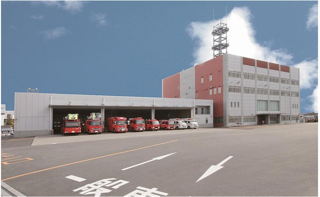
鈴鹿市消防本部・鈴鹿市中央消防署
