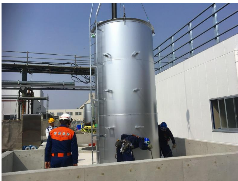
屋外タンク中間検査
