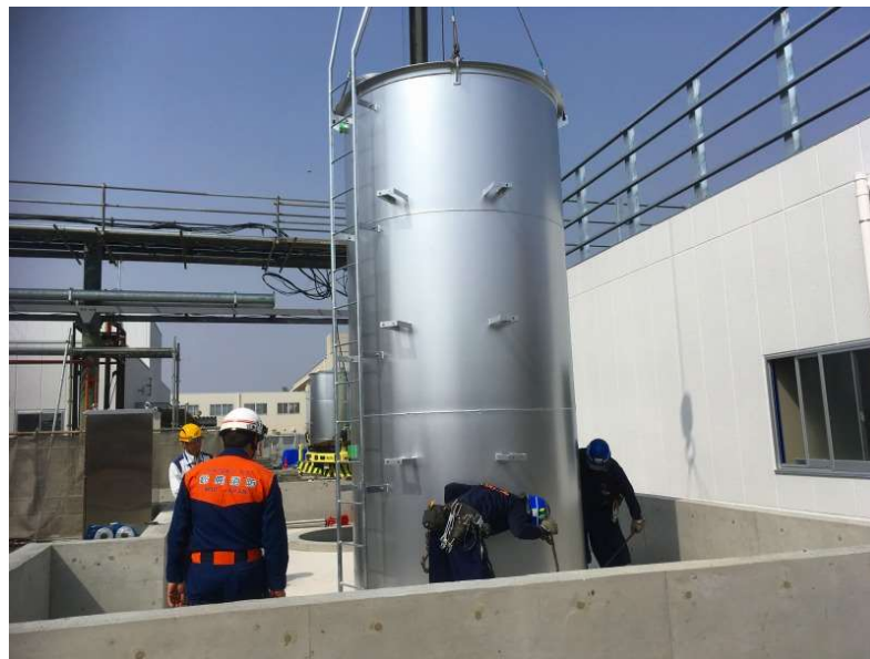
屋外タンク中間検査
