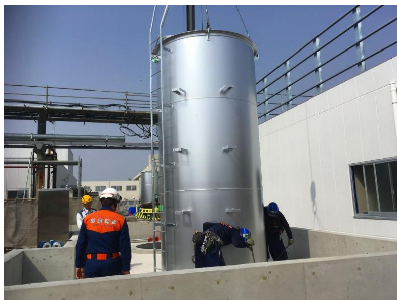
屋外タンク中間検査
