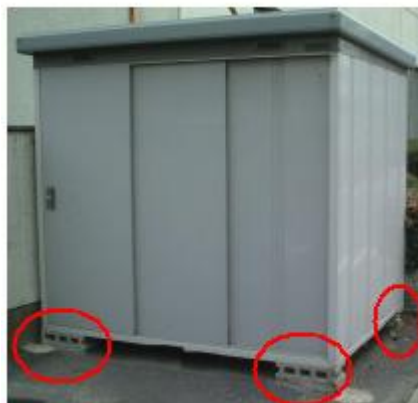
Depósito simples colocado em cima de blocos de cimento
