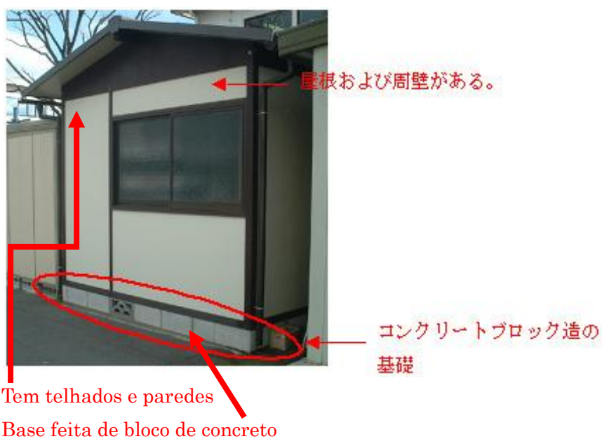
Depósito com base de bloco
