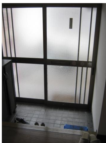
【建物出入口（中）】
