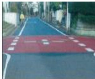
交差点カラー舗装
