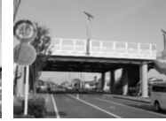
歩道橋一体型の津波避難タワー
