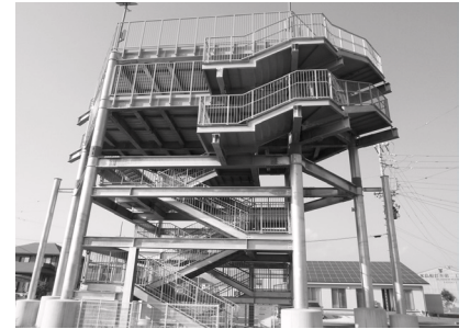
避難タワー(静岡県焼津市)
