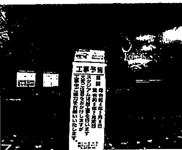
2月より工事着工を知らせる看板(3月末、工事は始まっていない)
