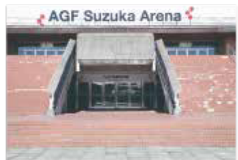
改修中の市立体育館
