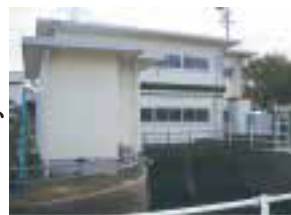
懸念される白子第3排水機場
