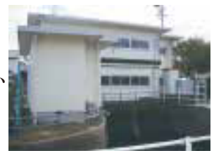
懸念される白子第3排水機場
