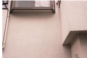
健全な外壁（ひび割れ等がない）
