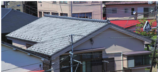
健全な瓦屋根
