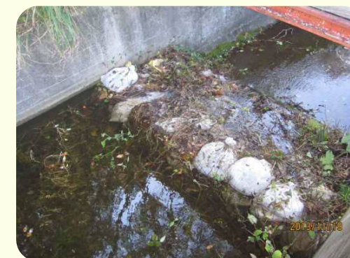
土のうによる洪水吐のかさ上げ
