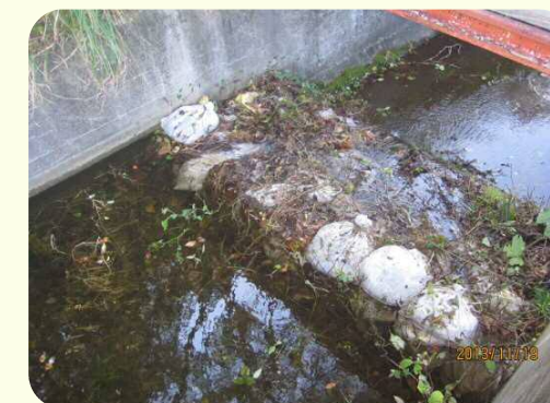
土のうによる洪水吐のかさ上げ
