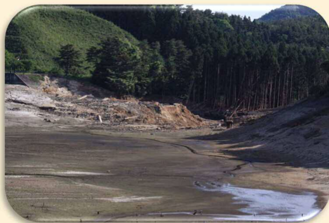
平成22年3月11日、東日本大震災により決壊した藤沼ダム(1,504千m3)
