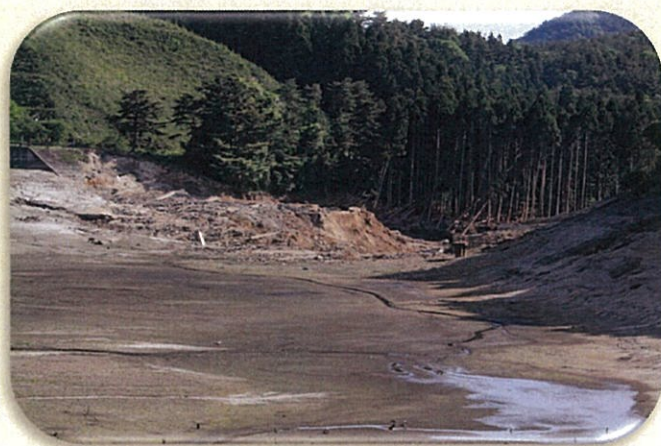
平成23年3月11日、東日本大震災により決壊した藤沼ダム(1,504千m3)
