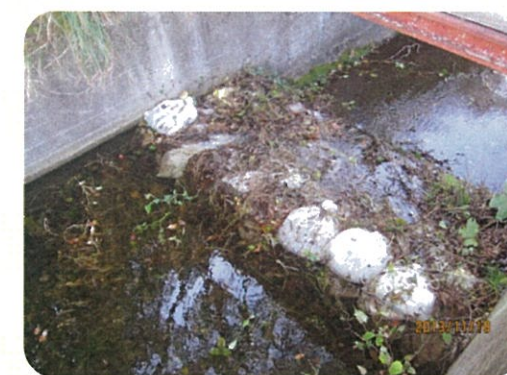
土のうによる洪水吐のかさ上げ
