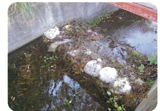
土のうによる洪水吐のかさ上げ
