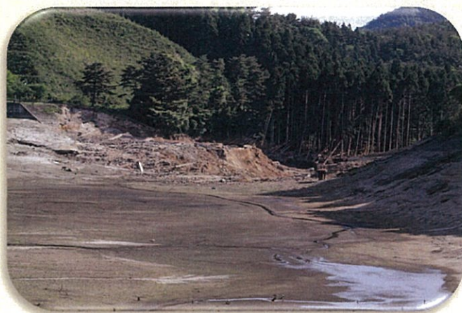
平成23年3月11日、東日本大震災により決壊した藤沼ダム(1,504千m3)
