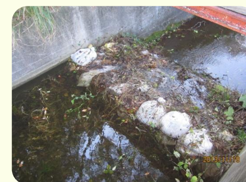
土のうによる洪水吐のかさ上げ
