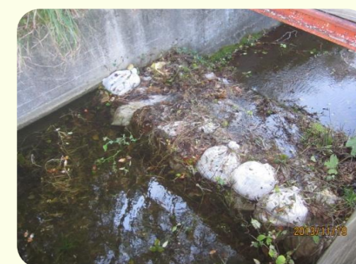
土のうによる洪水吐のかさ上げ
