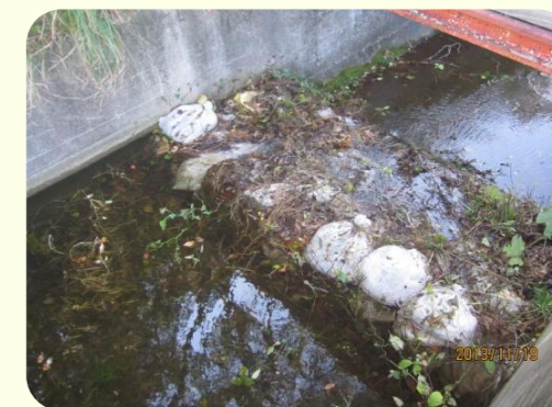
土のうによる洪水吐のかさ上げ
