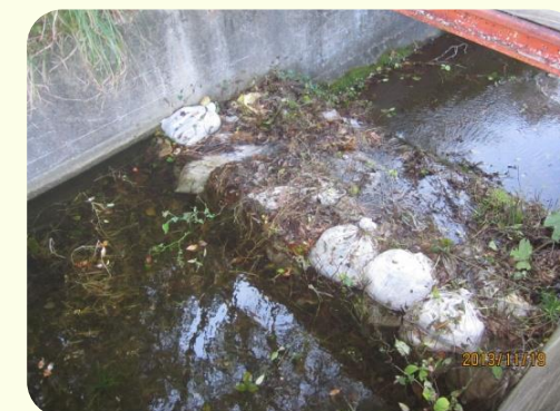
土のうによる洪水吐のかさ上げ
